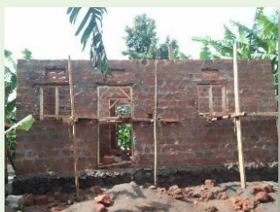
Baubeginn am 24.10. – Fertigstellung vor Weihnachten
