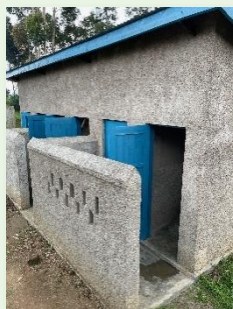
Neue Toiletten für eine ganze Schule
